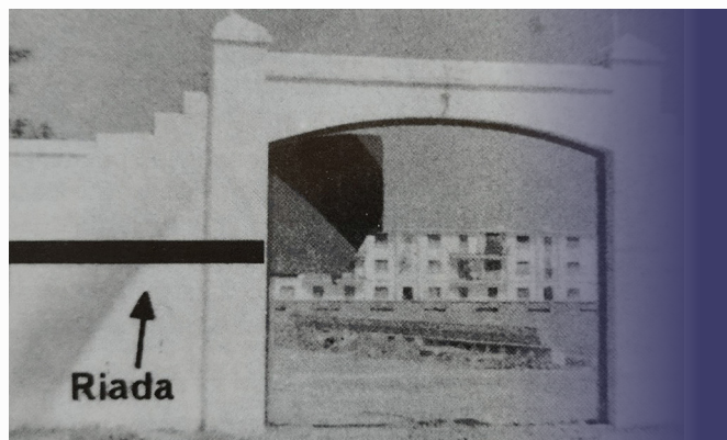
Imagen de la altura del agua en la fachada del Campo Municipal
